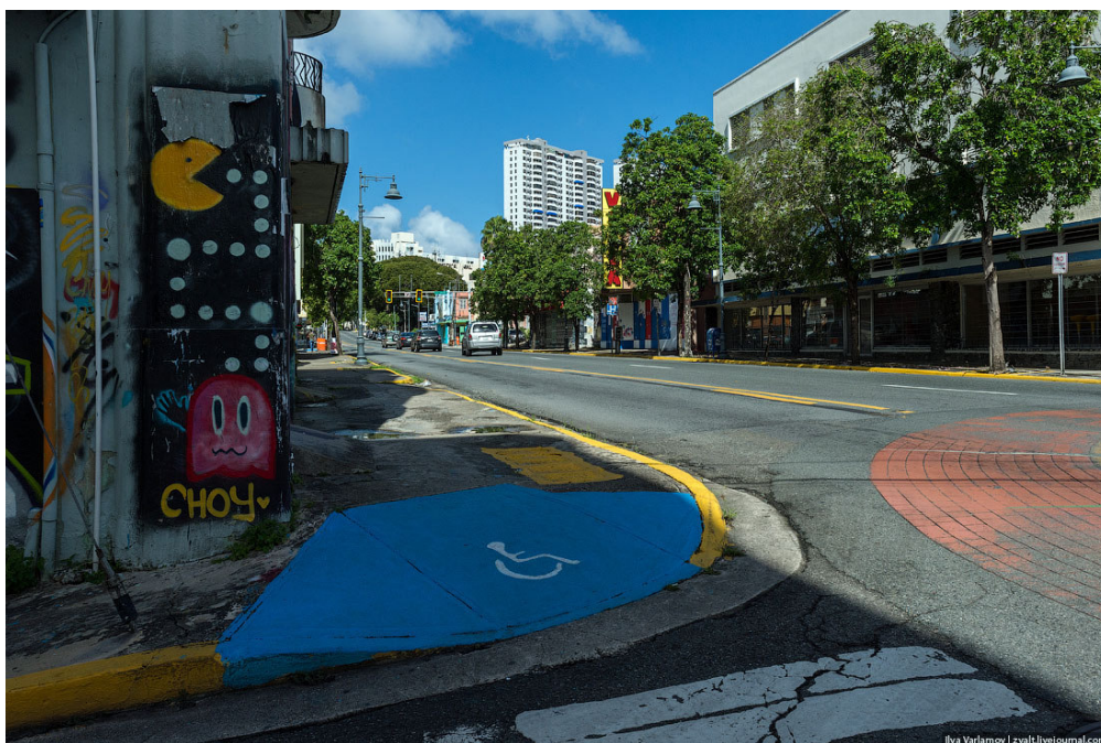
Рисунок 4.1412 – Пешеходный переход, обеспечивающий условия движения маломобильных групп граждан
